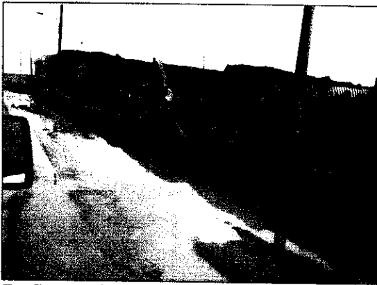
7.- Sector de calle saneada frente a planta
